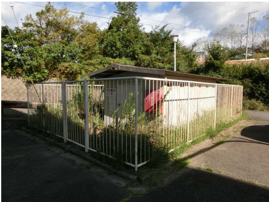
ボンベ室（西側から撮影）
