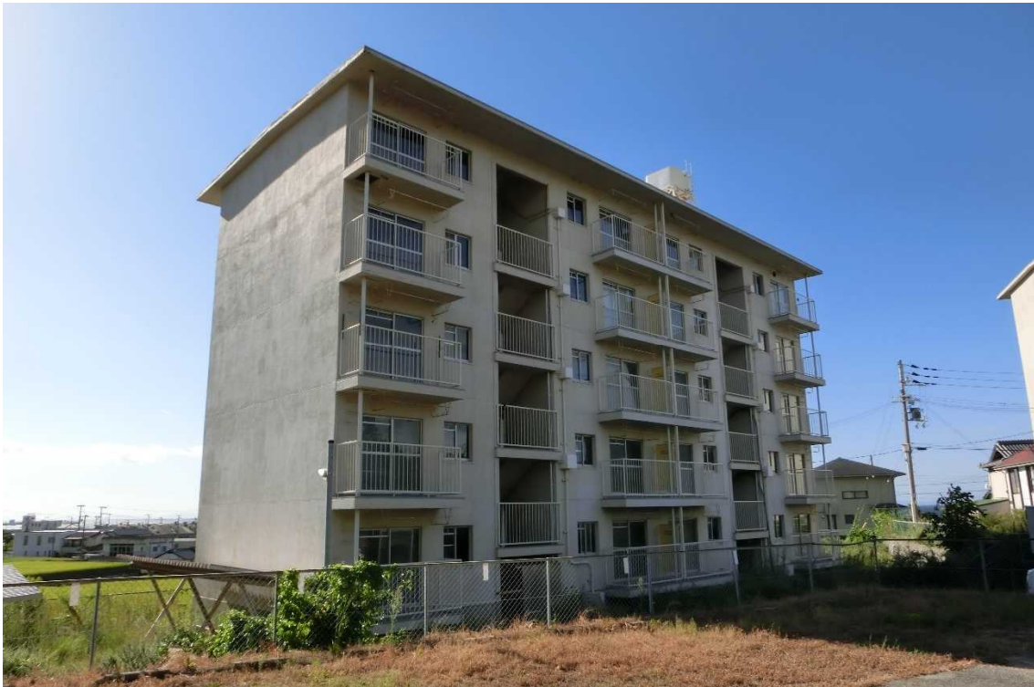
鉄筋 1 号棟 (南東側から撮影)
