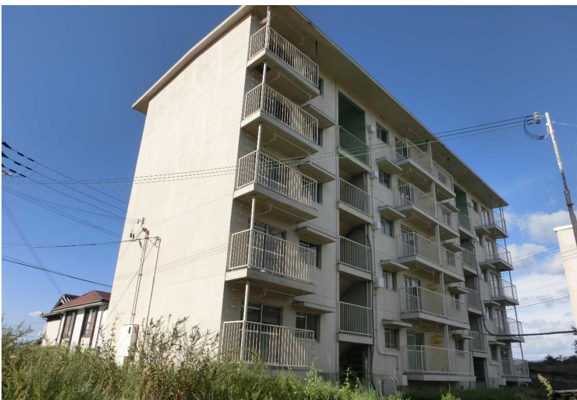
鉄筋 2 号棟 (南側から撮影)
